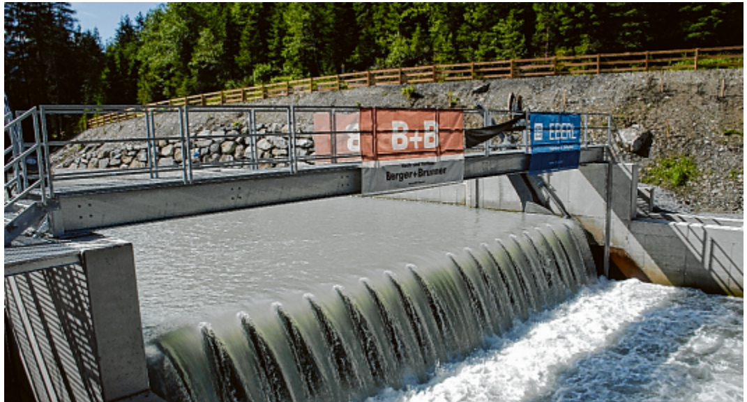
Hier am Wehr in Scheibbrand sollten künftig vier Kubikmeter pro Sekunde in den Druckstollen fließen. Fotos: Paschinger
