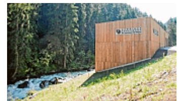
In wenigen Wochen geht das Krafthaus in den Probebetrieb.
