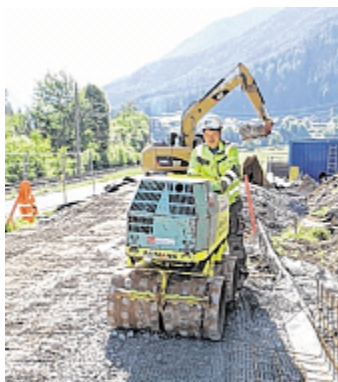
64 Meter weit schützt der künftige Damm Bahn und Radweg.
